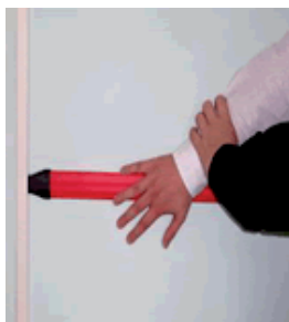
Poplachové spínače na stěnách místností na policejních stanicích, toaletách pro postižené, ve fitness centrech, domovech pro seniory,...
